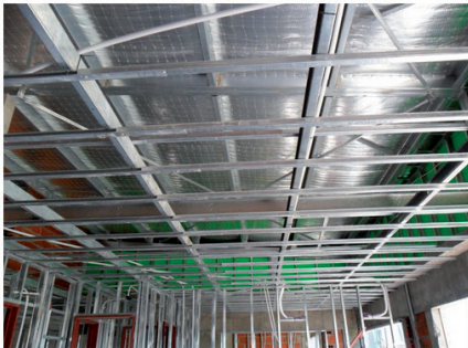
Utilización FielTRO Tensado Alu en cubierta.
