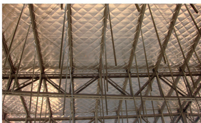
FielTRO Tensado Alu con estructura para cielorraso suspendido.
