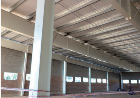
Utilización del Filtro Tensado en cubiertas nuevas.
