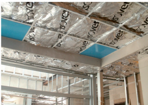
Rolac Plata Cubierta sobre cielorraso desmontable.
