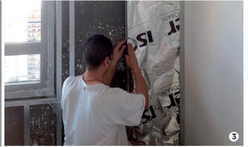
1. Montaje de montantes y soleras de separadas del muro. Para dar rigidez a la estructura, cada montante se tomará al muro a los tercios de la altura mediante 2 perfiles doblados en "L" con separador de neoprene. En caso de perfiles de 70 mm, no es necesario fijarlos al muro.
