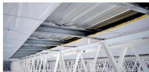
5. En estructuras similares a las de la imagen, donde no hay continuidad del FT Polipropileno se sugiere en el espacio libre entre la chapa y las cabriadas completar colocando un panel andina PVC. De esta manera tanto el aislamiento térmico como la barrera de vapor y la terminación estética son continuas y uniformes.
