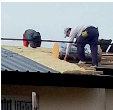
Las chapas se colocan a medida que se avanza con la colocación de la lana para evitar que quede expuesta.
