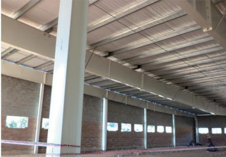
Utilización del Filtro Tensado en cubiertas nuevas.
