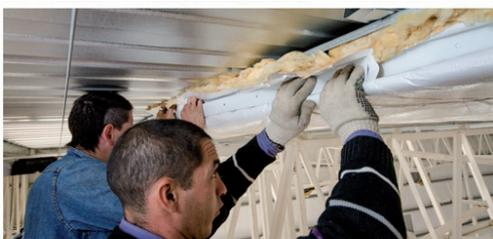
3. Cuando el largo del rollo sea inferior a la distancia a cubrir, el empalme con el segundo rollo se hará mediante una cinta autoadhesiva de polipropileno. Reforzar la unión con un fleje tomándolo a la correa.
