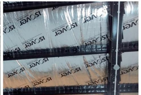
Utilización en cubiertas de chapa de pequeñas luces.
