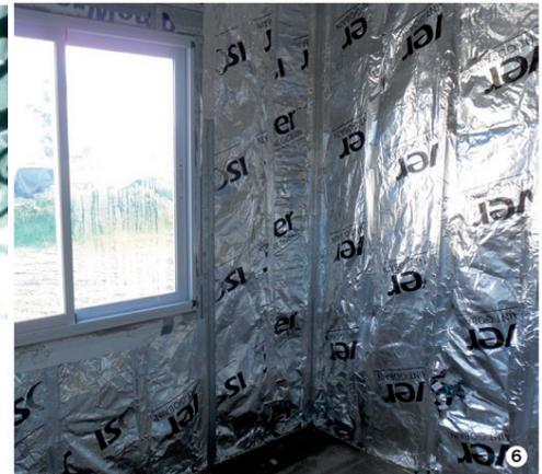
4 y 5. Unión de paños (solapa y revestimiento) con cinta autoadhesiva de aluminio.
