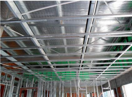
Utilización FielTRO Tensado Alu en cubierta.
