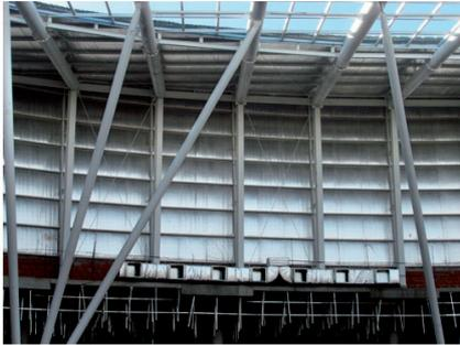
Utilización FielTRO Tensado Alu en cubierta y cerramiento vertical.
